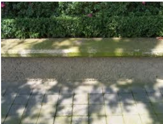
Banquetas de concreto
