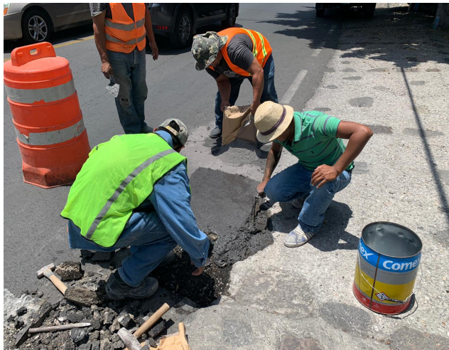
Proceso de reparación
