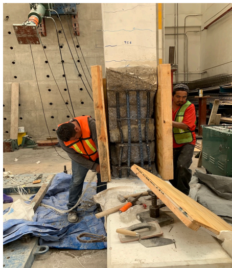
Cimbrado de la columna
