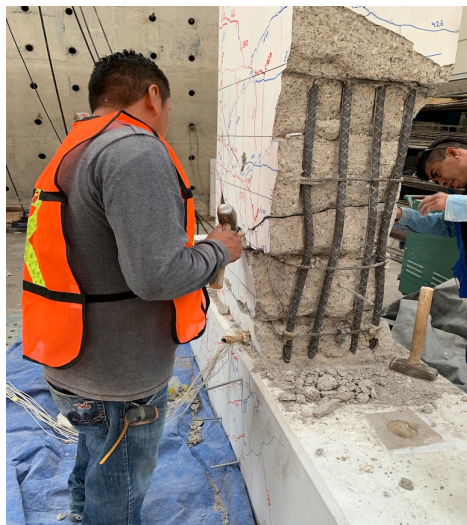
Preparación de la columna
