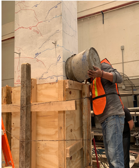
Colado de columna
